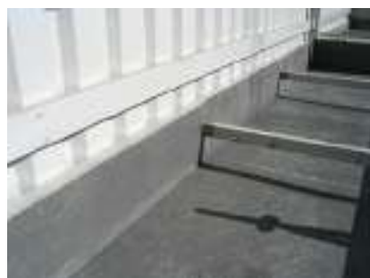
Rivestimento in resina nelle vaschette o all'interno
